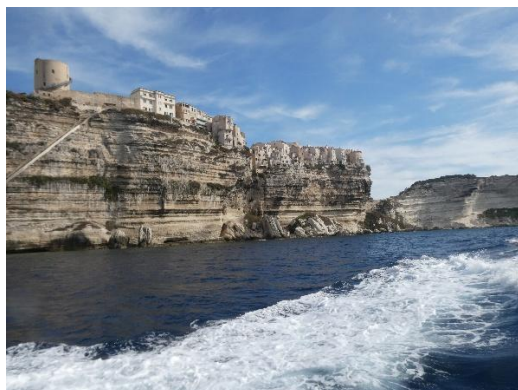
L'escalier du Roy d'Aragon
